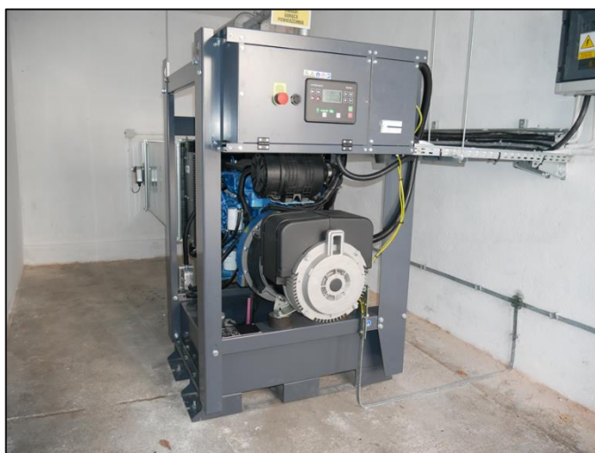
Zdjęcie 29, 30. Zamontowany w starostwie automatyczny agregat prądowy
