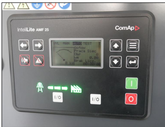
Zdjęcie 29, 30. Zamontowany w starostwie automatyczny agregat prądowy
